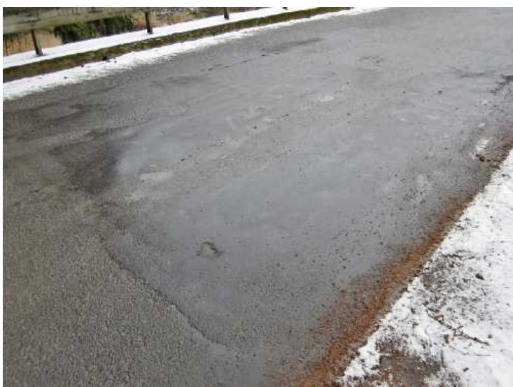
Poruchy v krytu vozovky v poli 1.
