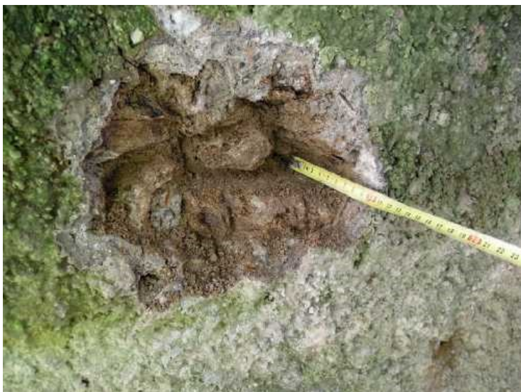
Detail hloubkového rozpadu spárové malty klenby, pole 1, levá část.
