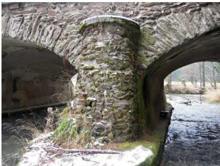
Pilíř P2, levá - návodní strana, uchycené traviny i dřeviny ve zdivu, v dolní části zdivo narušené, lokálně rozvolněné.
