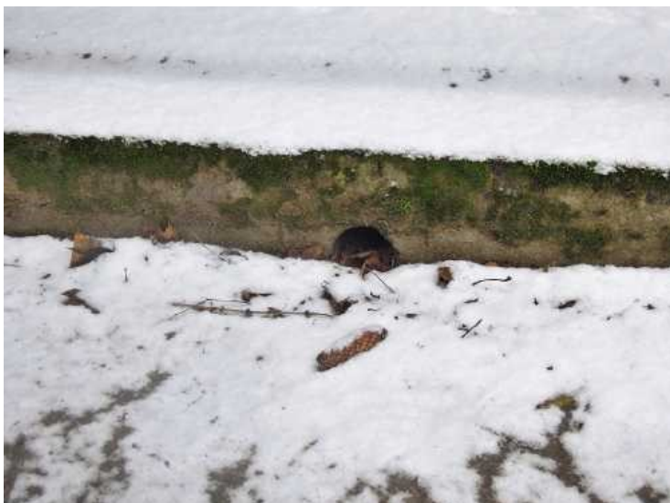
Odvodnění mostu - příčně zabetonované trubky procházející římsou ve vrcholu klenby - částečně zanesené - pravá strana, pole 1.
