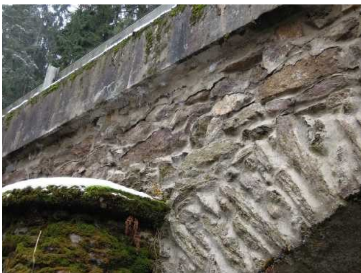
Hlava pilíře P2, pravá strana, popraskané spárování čelní zdi.
