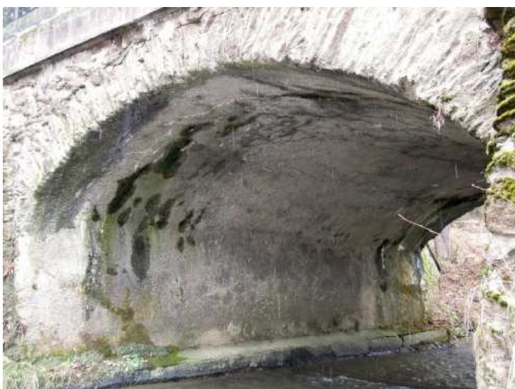
Opěra 1, pole 1, pravá strana, pohled do mostního otvoru silné průsaky, krápníky, trhliny.
