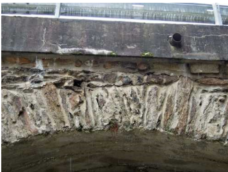
Vrchol klenby v poli 2, levá strana, průsaky, popraskané zdivo čelní zdi.
