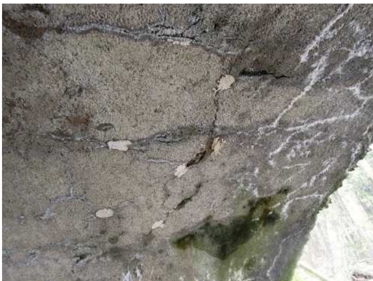
Osazené sádrové terče přes trhliny v poli 1, levá strana. Terče přes podélné trhliny jsou porušené.
