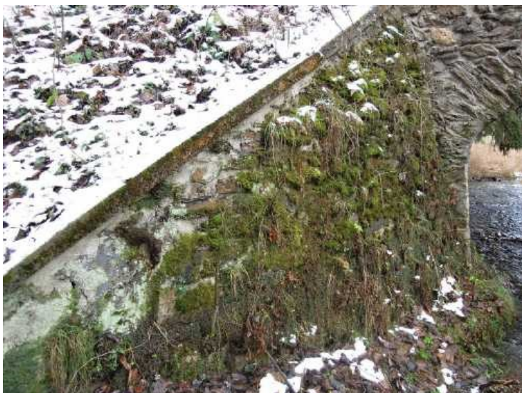
Pravé křídlo opěry 1, vegetace a mech ve sparách zdiva. Zdivo narušené - popraskané spáry.
