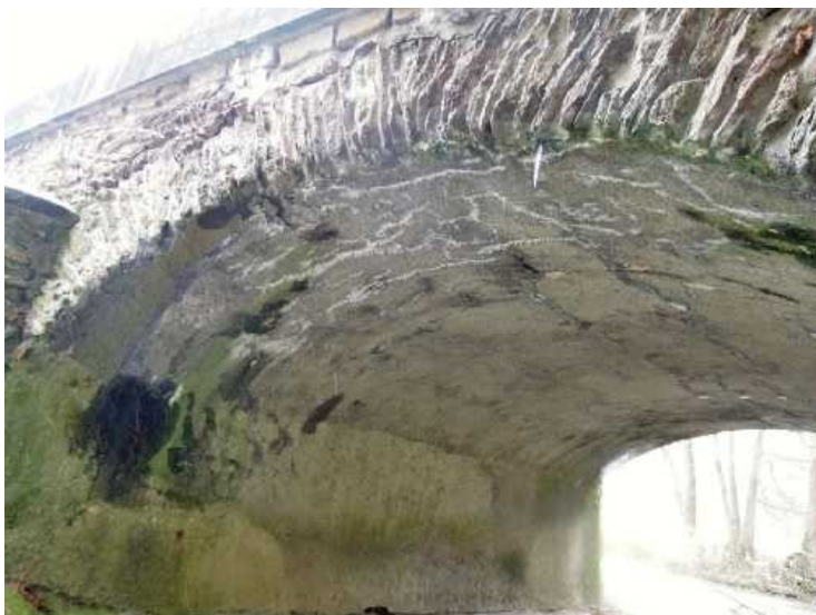
Pole 1, levá strana, průsaky, trhliny s výluhy na podhledu klenby.
