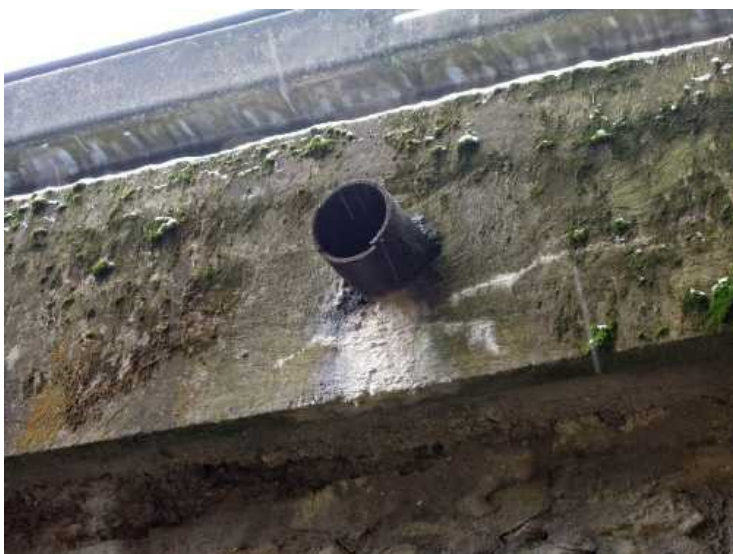
Levá římsa v 1.poli, vyústění trubky odvodnění vně římsy, výluhy pod trůbkou.
