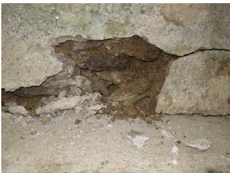
Pilíř P2, odtržená vrstva torkretu, hloubkový rozpad zdiva pilíře v místě ochranného prahu v korytě.
