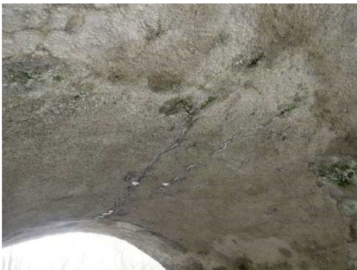
Pole 2, příčné trhliny ve vrcholu klenby, průsaky v klenbě.
